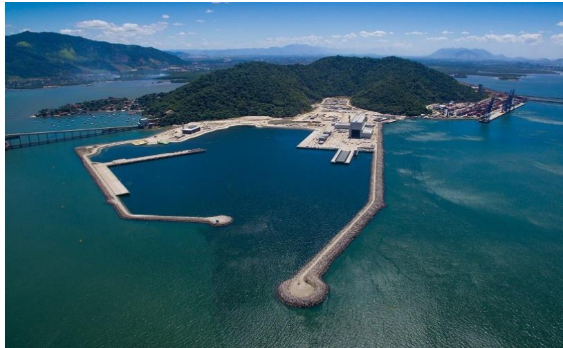
Figura 15 - Estaleiro e Base Naval de Itaguaí-RJ
