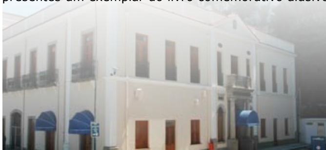
Prédio do Serviço de Identificação da Marinha, no Rio de Janeiro
