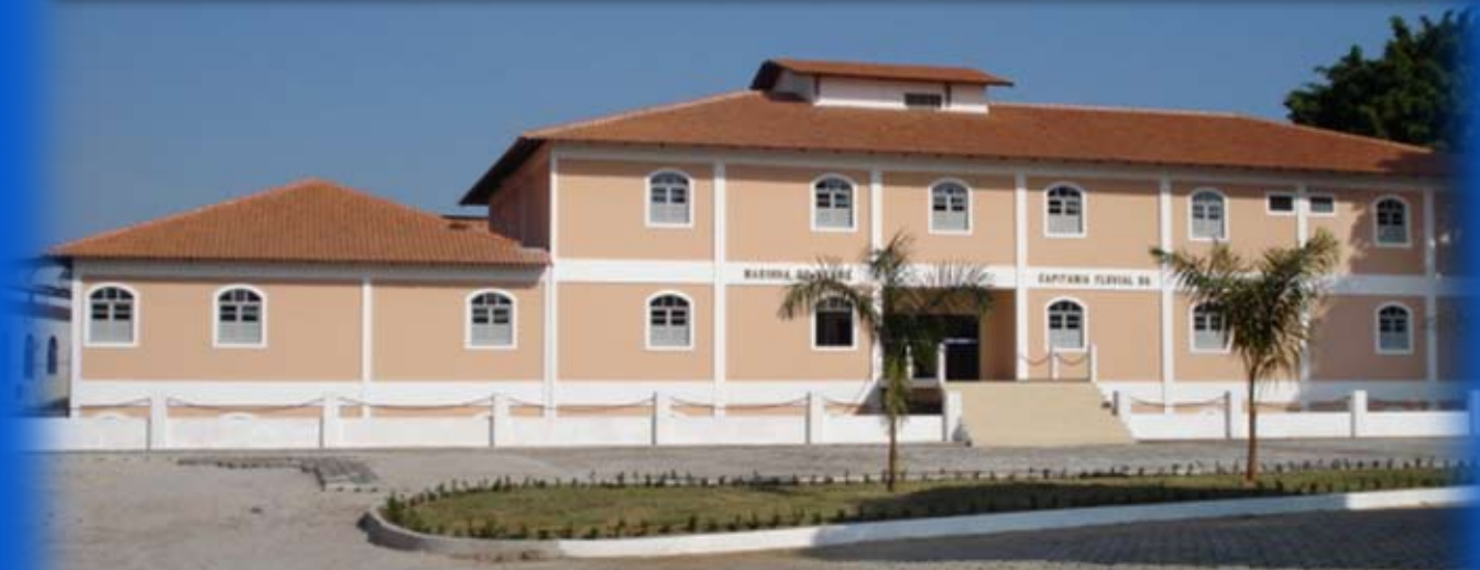
Novo prédio da CFAOC valoriza o Centro Histórico de Manaus
