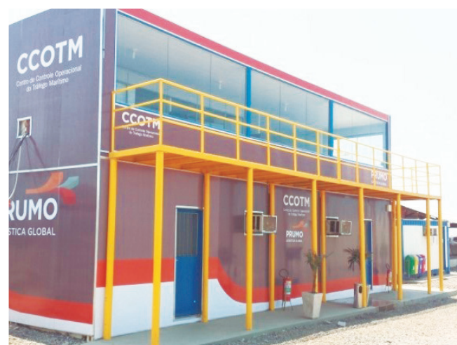
Instalações do Centro VTS do Porto do Açu
