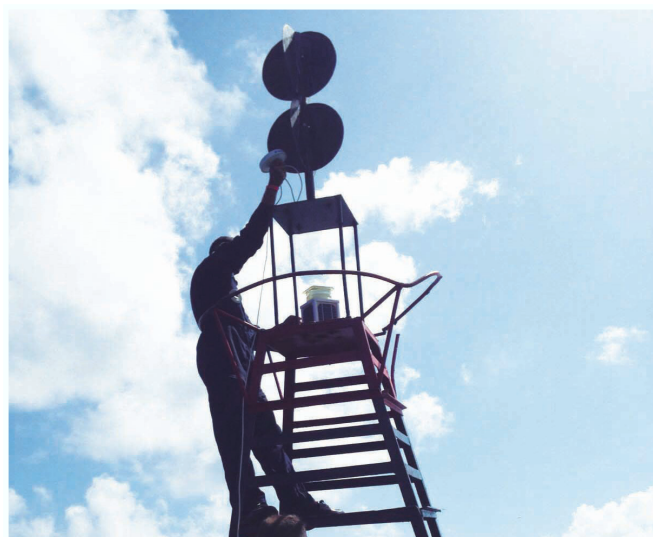
Reposicionamento da boia de Perigo Isolado
