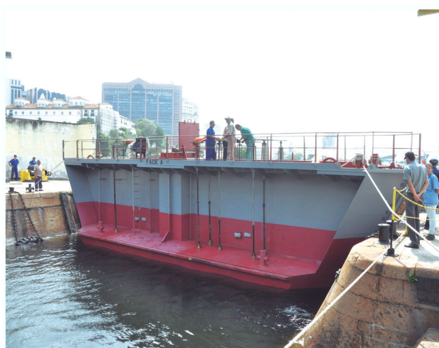
Porta batel do dique Santa Cruz
