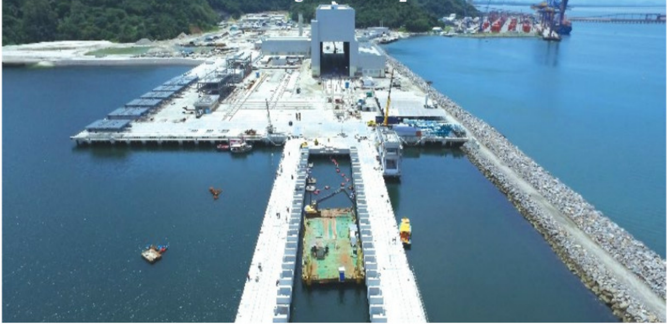
Estrutura do shiplift em construção
