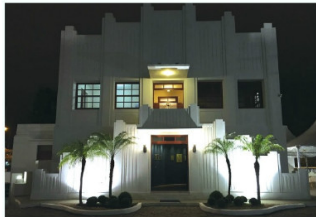
Fachada do CCMSC em Florianópolis (SC)
